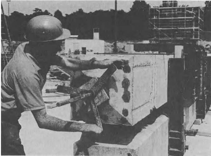
Abb. 7. Pädagogische Akademie Ludwigsburg. Vorrichtung zum Zusammenpressen der Kunstharzfugen zwischen den vorgefertigten Teilstücken der 18 m langen Stützen
